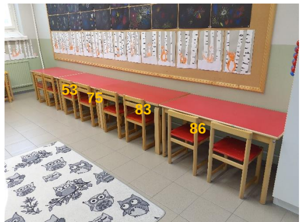
Kuva 54. Pintakosteusarvot koholla seinän alaosassa. Osa 1, kellari, pienluokatila.
