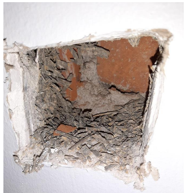
Kuva 63. Sementtilastulevystä otettiin näyte laboratorioon.
