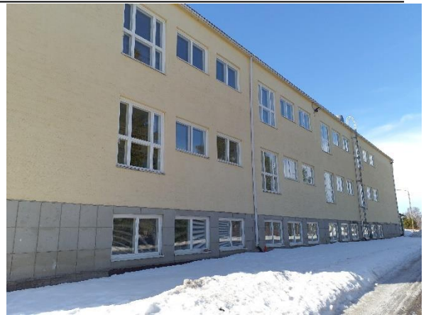
Kuva 5. Rakennuksen (osa 1) koillissivulla on uusittu rakennuksen kuivatusjärjestelmiä ja laskettu maanpinnan tasoa.
