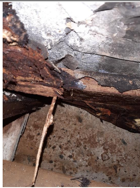
Kuva 29. Kuva ulkoseinän viereltä käytävän keskiosaan päin kuvattuna. Kuvan perusteella kanaali ulottuu ulkoseinästä n. 0,7 m etäisyydelle.
