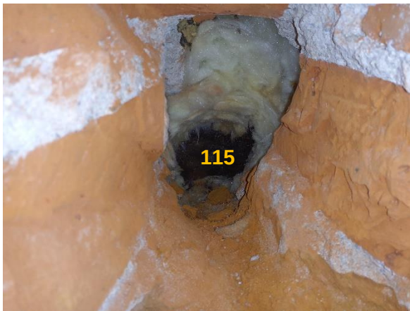
Kuva 47. Eristekerroksen takana on betonirakenteinen perusmuuri, jonka sisäpinnassa on pikisively. Mineraalivilla oli märkää tutkimuskohdassa.
