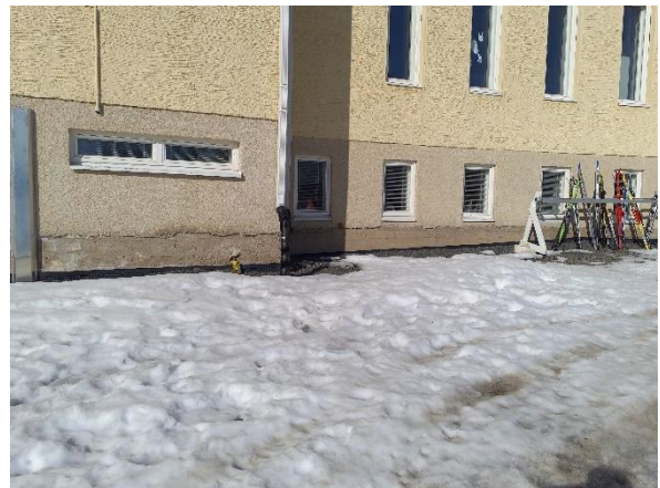
Kuva 3. Rakennuksen kaakkoissivulla (osa 1) on uusittu rakennuksen kuivatusjärjestelmiä ja laskettu maanpinnan tasoa.
