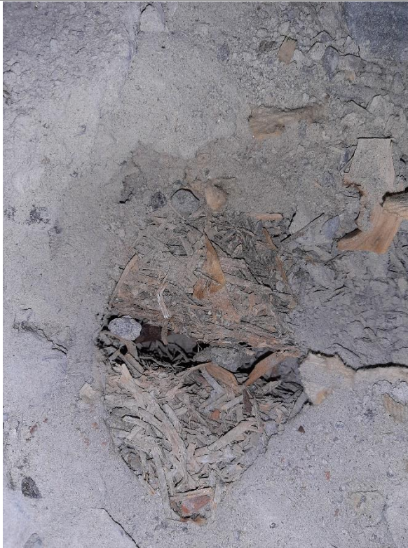
Kuva 92. Yläpohjan eristeenä on sementtilastulevy, jonka yläpuolella on rakennuspahvi.
