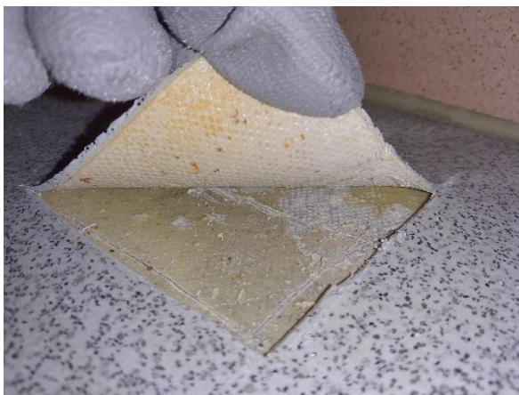
Kuva 24. Tutkimuspiste KL5. Käytävä 010.
