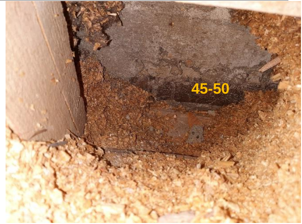
Kuva 67. RAK 5. Välipohjarakenteen eristetilaa alaosaan ulkoseinän betonirakenteen vierestä otettiin näyte eristeestä mikrobialyysiin. Näytteen analyysitulokset viittaavat vaurioon. Betonirakenteet olivat kuivia.
