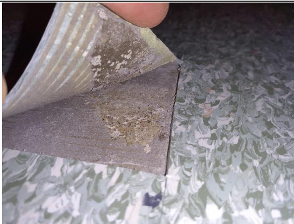
Kuva 20. Tutkimuspiste KL1. Vahva pistävä haju maton alla. Sos.tila 036.
