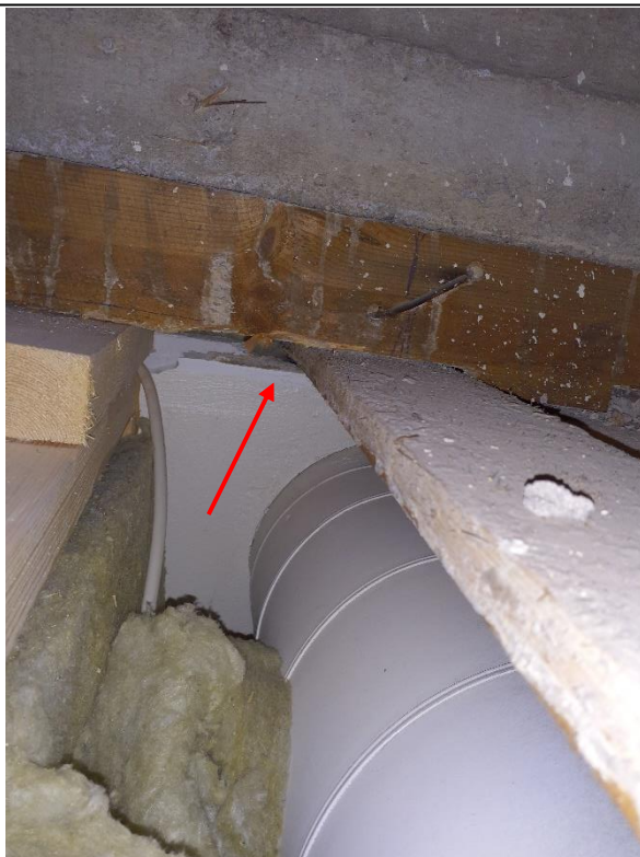
Kuva 120. Ilmayhteys kotelorakenteeseen. Luokka 2.
