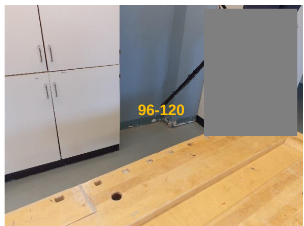
Kuva 56. Pintakosteusarvot koholla seinän alaosassa. Osa 1, kellari, luokkatila.
