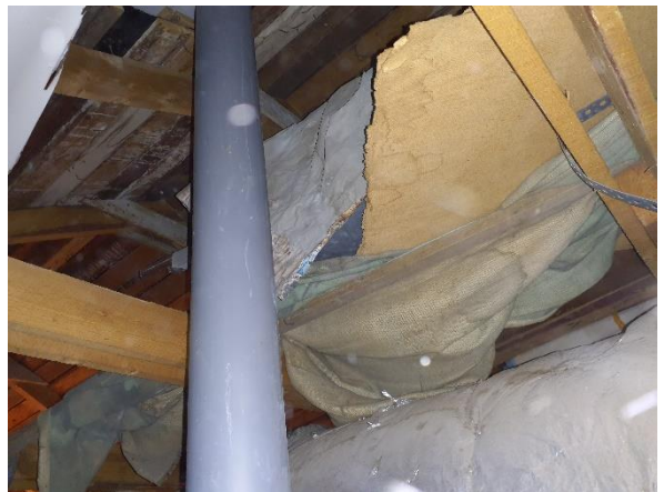
Kuva 79. Sama kohta kuin edellinen kuva. Kosteusvauriojälkiä tuuletusputken ympärillä rakennusmateriaaleissa ja irtaimistossa.
