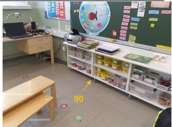
Kuva 56. Pintakosteusarvot koholla seinän alaosassa. Osa 1, kellari, luokkatila.
