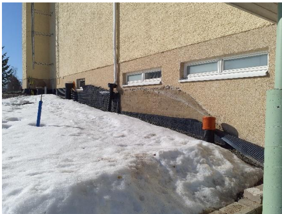
Kuva 2. Rakennuksen kaakkoissivulla (osa 1) on uusittu rakennuksen kuivatusjärjestelmiä ja laskettu maanpinnan tasoa.
