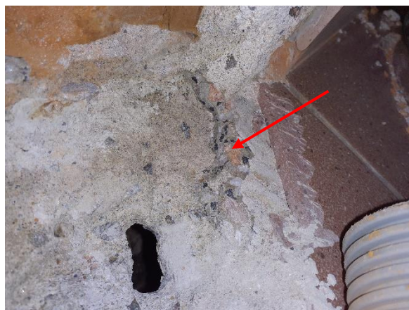
Kuva 27. Lattiapinnoitteen alla on kova kivipohjainen materiaalikerros, jonka alla betonirakenne putkikanaalin kattona.
