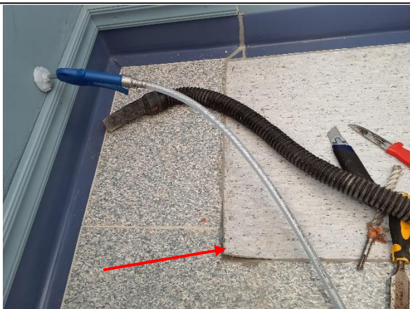
Kuva 73. Kaasu syötettiin nuolen osoittamasta kohdasta välipohjan ontelotilaan.
