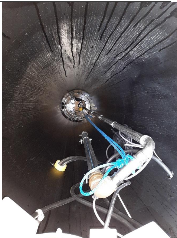
Kuva 13. Salaojajärjestelmä on uusittu rakennuksen koillis- ja kaakkoissivulle. Rakennuksen eteläkulmassa on kaivossa pumppu.
