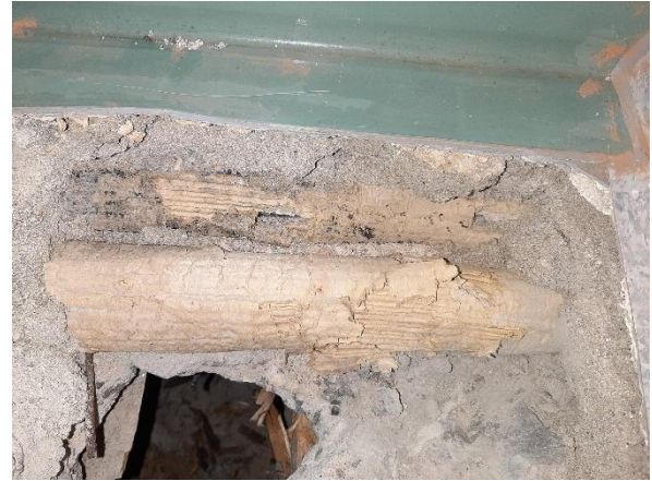
Kuva 67. RAK 5. Välipohjarakenteen eristetilaa alaosaan ulkoseinän betonirakenteen vierestä otettiin näyte eristeestä mikrobialyysiin. Näytteen analyysitulokset viittaavat vaurioon. Betonirakenteet olivat kuivia.
