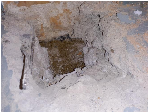
Kuva 31. Tutkimuspiste sijaitsee ulkoseinän vieressä. Lattian betonirakenteen alla on EPS-eristettä 100 mm ja sen alla on hienojakoinen ja kostea hiekka.
