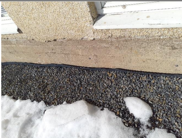
Kuva 4. Uudesta perusmuurilevystä puuttuu yläistä. Asennustyö on vielä kesken.
