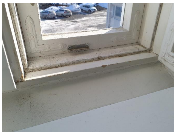
Kuva 49. Vanhan osan ikkunat ovat huonokuntoiset. Kuva toimitusohoneesta.
