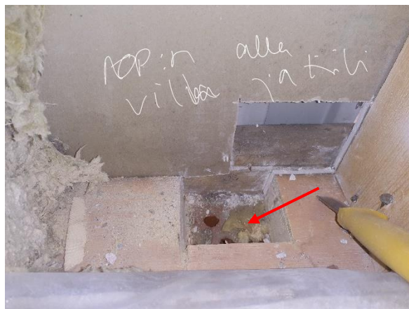
Kuva 48. Vaakakoolauspuun alla on mineraalivillaa ja tiiliä. Vaakakoolauspuussa (Näyte 9, Analyysivastaus MIK9272) ja mineraalivillassa (Näyte 10, Analyysivastaus MIK9272) todettiin viite vauriosta mikrobianalyysin perusteella.
