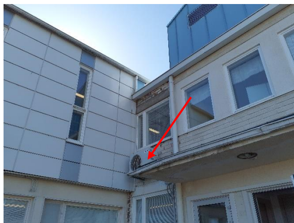
Kuva 37. Tutkimuspiste RAK1 sijaitsee ulkoseinän osalla, jossa seinän ulkoverhous on tiilirakenteinen.
