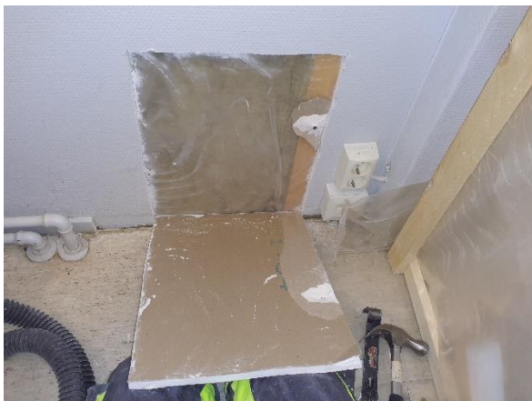
Kuva 45. Tutkimuspiste sijaitsee vanhan ja uuden osan liittokohdassa.
