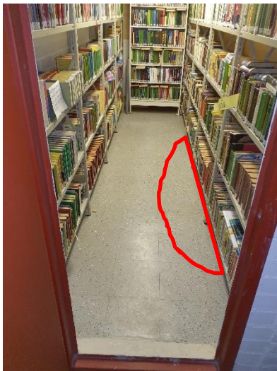
Kuva 4. Tilan C lattiassa todettiin kohonneita pintakosteusarvoja. Lattianpinnoitteena olevat muovilaatat ovat paikoin kuprulla.
