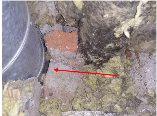
Kuva 64. Ilmanvaihtokanavan läpivienti yläpohjarakenteessa on epätiivis kirjaston infopisteen kohdalla.
