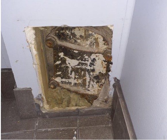
Kuva 15. Nuorisotilan eteisen viereisen wc:n kotelorakenteeseen laskettiin merkkiainekaasua.
