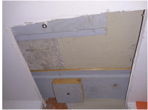
Kuva 106. Hormin pinta on osittain maalattu ja tasotettu, mutta osittain se on pinnoittamaton tiilirakenne.
