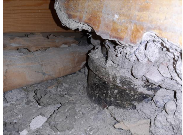
Kuva 108. Kotelorakennetta avattiin ja sen sisällä todettiin viemäriputki ja käytöstä poistettuja lämmitysputkia.
