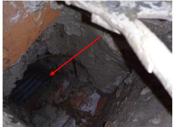
Kuva 20. Sama tila kuin edellinen kuva. Korvausilmaventtiin takana on korvausilma-aukko suoraan ulos. Ulkopuolella on säleikkö.
