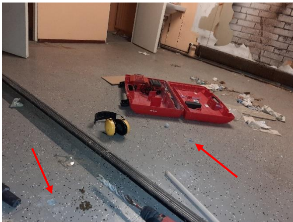
Kuva 2. Tutkimuspiste RAK10. Tilassa on osittain korotettu lattia ja muovilaattapinnoite.
