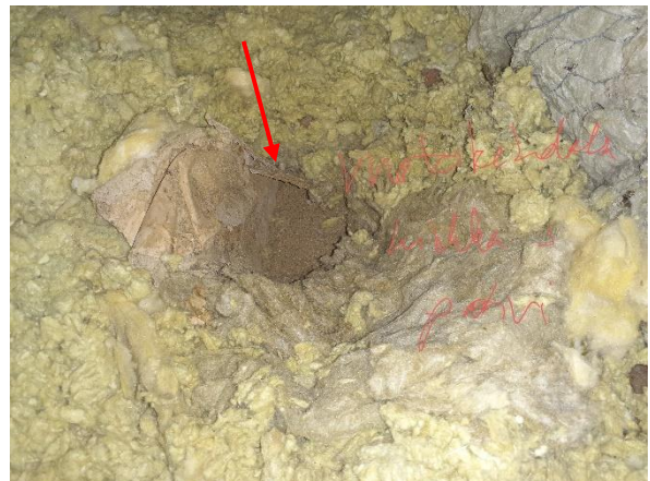
Kuva 64. Ilmanvaihtokanavan läpivienti yläpohjarakenteessa on epätiivis kirjaston infopisteen kohdalla.
