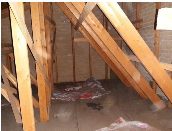
Kuva 69. Yleiskuva ullakkotilasta Oravanpesän kohdalla. Eristeiden päällä paikoin rakentamisen aikaisia muovijätteitä.
