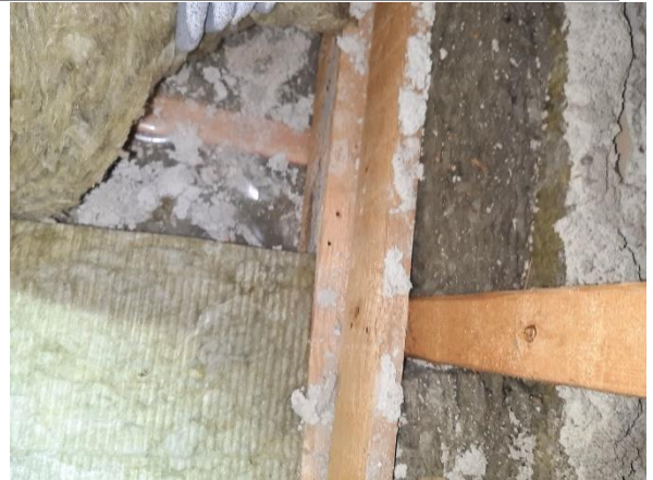
Kuva 72. Muurauslaastia yläpohjan höyrynsulkumuovin päällä.
