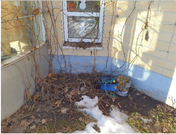
Kuva 12. Paikoin rakennuksen sokkelin vieressä on istutuksia.
