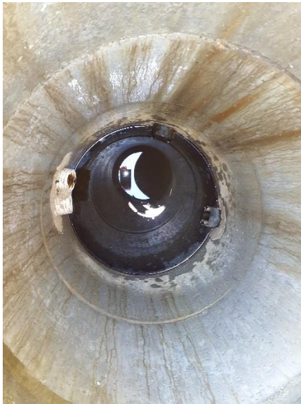
Kuva 14. Yleiskuva salaojakaivosta. Kaikissa tarkastetuissa kaivoissa veden pinta oli putkien alapuolella.
