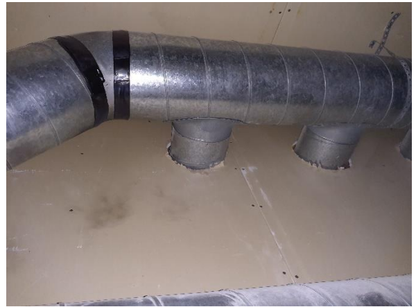
Kuva 86. Iv-kanavien läpiviennit alakaton yläpuolisesta tilasta päiväkodin huonetiloihin päin. Käytävä A115.
