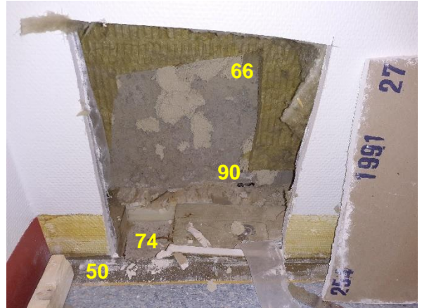
Kuva 49. Sokkelin ulkokuoren alaosa on märkä.
