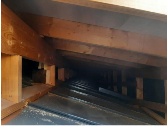
Kuva 83. Keittiön osalla on uusi vesikatto asennettu vanhan päälle.
