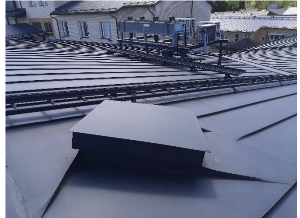
Kuva 96. Keittiön osalla on vesikate uusittu.
