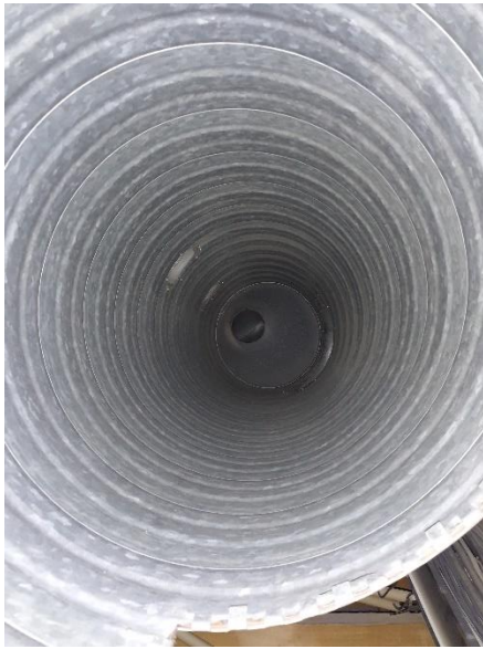
Kuva 111. Ketunkolon käytävällä tuloilmakanava tutkimuspisteessä IV1. Ei silmämääräisesti havaittavaa pölykertymää.
