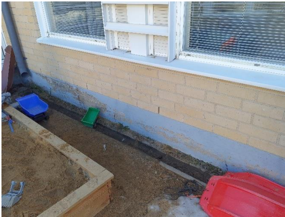
Kuva 4. Kahdessa kohdassa syöksytorvesta vesi on johdettu betonikouruun. Kuva Oravanpesän lepotilan C149 kohdalta.
