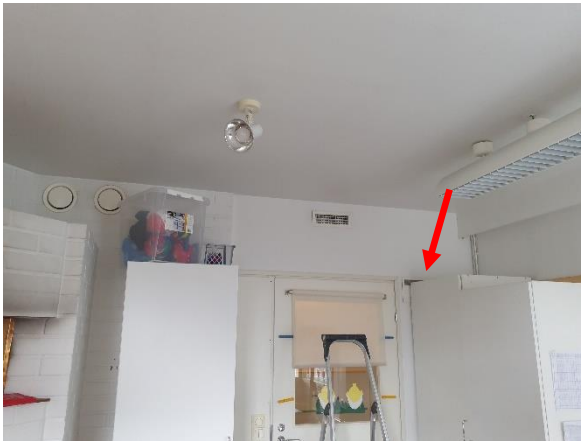
Kuva 109. Oravanpesän keittiössä on mineraalivillaa sisältävä siirtoilma-aukko käytävän väliseinässä.
