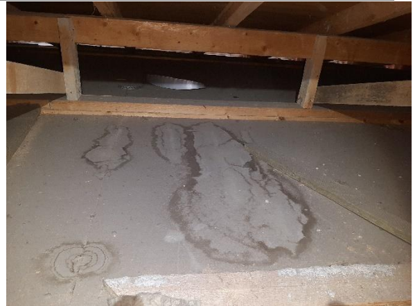
Kuva 80. Myyränmajan kohdalla kosteusjälkiä yläpohjan eristeiden päällä.
