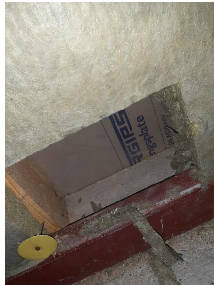
Kuva 130. Yläkerran toimistohuoneen D201 seinärakenteen kuntoa tutkittiin ullakkotilan kautta. Rakenteessa ei havaittu tavanomaisesta poikkeavaa.
