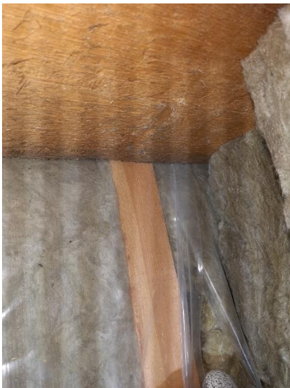
Kuva 81. Yläpohjan höyrynsulun limitys on 5 cm. Höyrynsulkumuovin alapuolella on mineraalivillaa.
