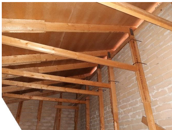
Kuva 70. Yleiskuva ullakkotilasta Oravanpesän kohdalla.
