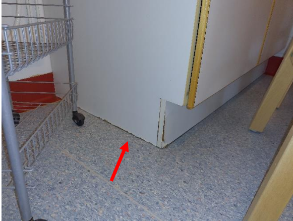
Kuva 127. Kaapin alaosassa kosteuden aiheuttamia vaurioita Ketunkolon pienryhmätalassa A112.
