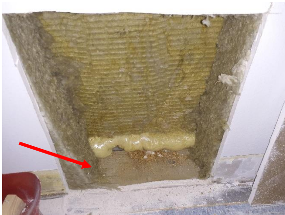
Kuva 37. Ulkoseinän eristeen alaosassa ei todettu viitettä vauriosta (Näyte 1, MIK9231) mikrobianalyysin perusteella.
