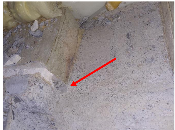
Kuva 42. Ulkoseinän höyrynsulku päättyy alapohjan runkolaatan yläpinnan tasolle.
