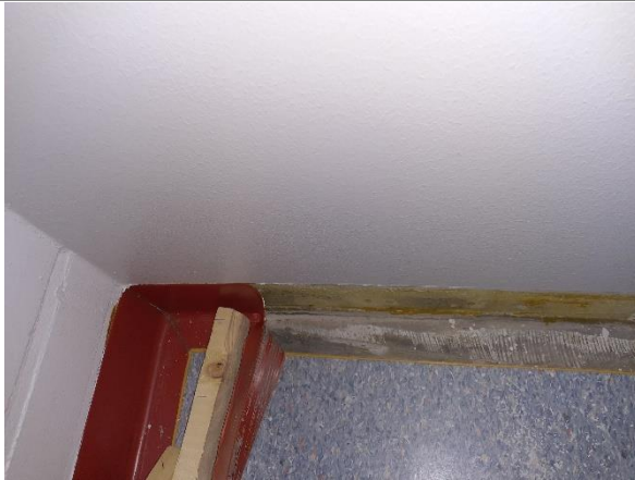
Kuva 35. Tutkimuspisteen kohdalla lattia- ja seinärakenteen liittymä on melko tiivis.
