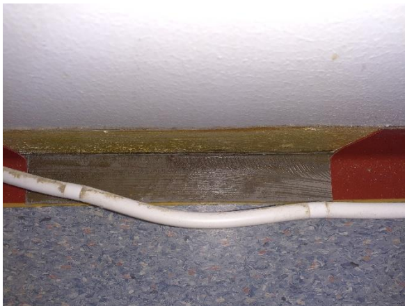
Kuva 61. Tutkimuskohdalla rakenneliittymä on melko tiivis.
