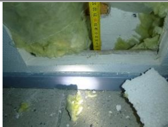
Rakenneaukaisu ruokasalin ulkoseinässä.
