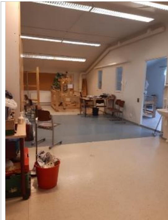
Yleiskuva yläkerran tiloista.
