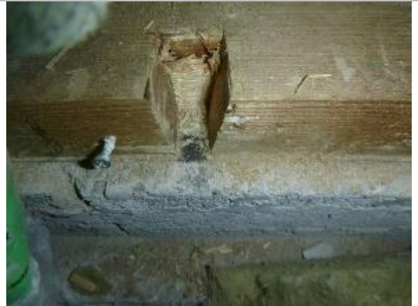
Alaohjauspuussa ei ole havaittavissa vaurioitumista. Alla on huopakaista.
