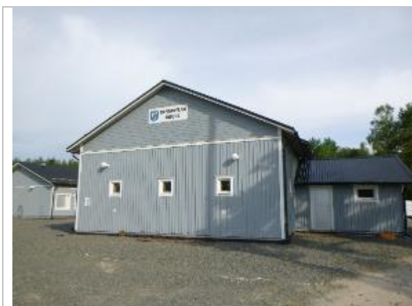
Ympäröivä maanpinta viettää rakennuksesta pois päin.
