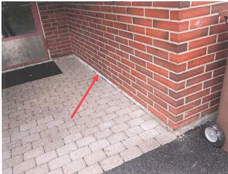
Kuva 7. Sokkelissa härmettä keittiön sisäänkäynnin edustalla.
