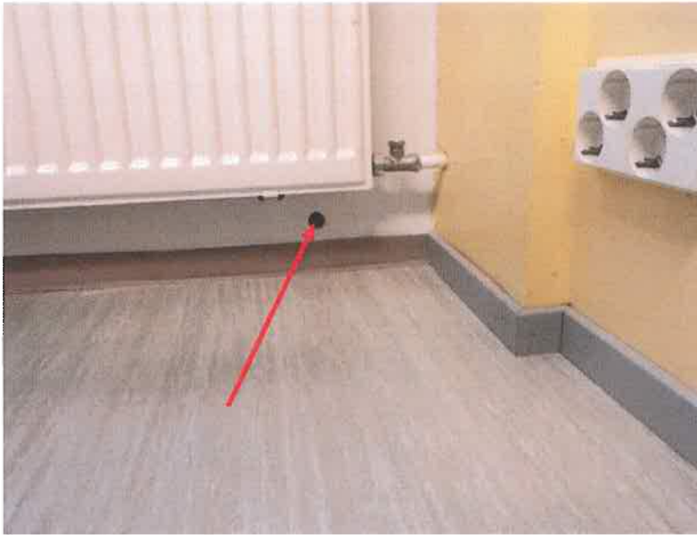
Kuva 10. Tila 145, näyte nro 3 ulkoseinärakenteesta.
