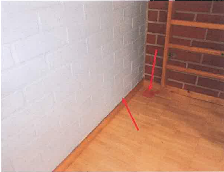
Kuva 4. Liikuntasalin nurkka, tiiliseinän sisäpinnasta näyte 6 ja lattiarakenteen villaeristeestä näyte 7.
