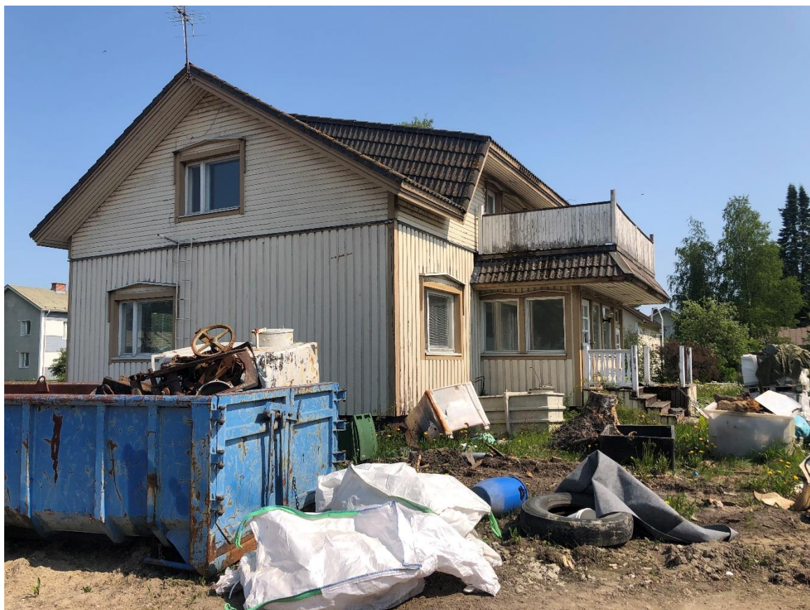
Kuva 2 Tulevan hybridikeskuksen tontilla sijaitseva purettava rakennus, kuvattuna Lehtokujan puolelta
